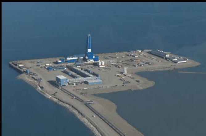
Borrningar har nyligen inletts med Liberty Rig vid Gull Island
